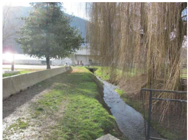
4/ Canalisation du Nant Pottier
