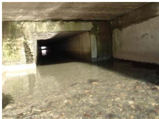
Dessous du pont de l'Avenue Général de Gaulle
