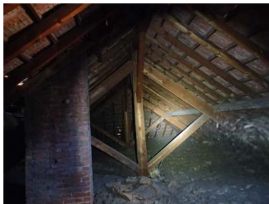
Bâtiment potentiellement favorable aux chiroptères
