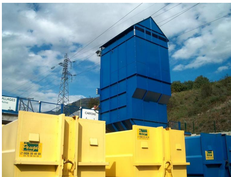
Quai de transfert de Valezan
