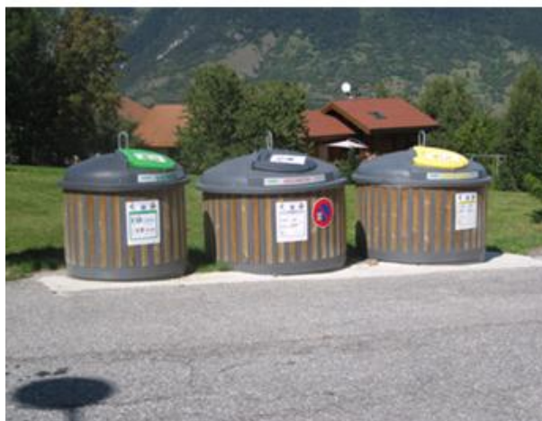
Une grappe de conteneurs semi-enterrés
