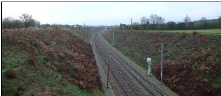
La voie de chemin de fer en déblais en partie nord de la commune
