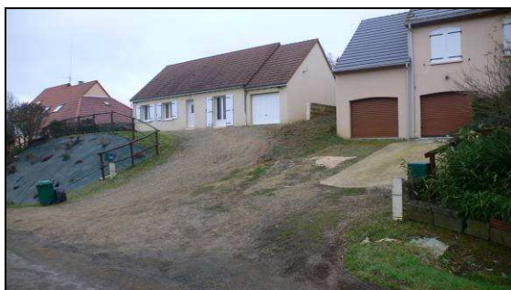
Rampes d'accès aux garages
