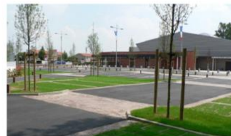
Aménagement paysager d'aires de stationnement : noue centrale empierrée et plantée à gauche, stationnement enherbé sur structure alvéolaire à droite
