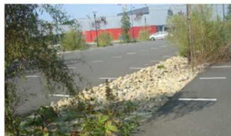
Aménagement paysager d'aires de stationnement : noue centrale empierrée et plantée à gauche, stationnement enherbé sur structure alvéolaire à droite
