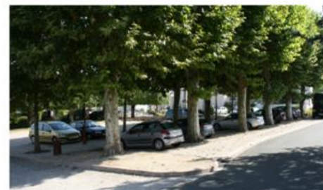
Aménagement paysager d'aires de stationnement : noue centrale empierrée et plantée à gauche, stationnement enherbé sur structure alvéolaire à droite
