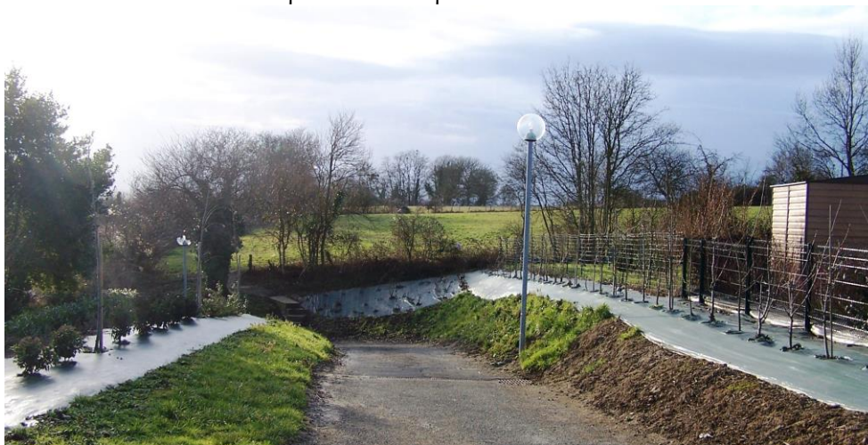
Vue du piétonnier du lotissement existant vers la zone de Vincennes
