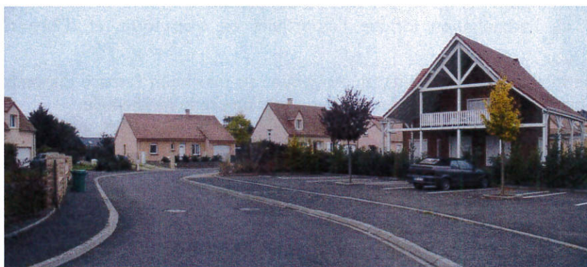
Source : Cabinet X. DEWAILLY
