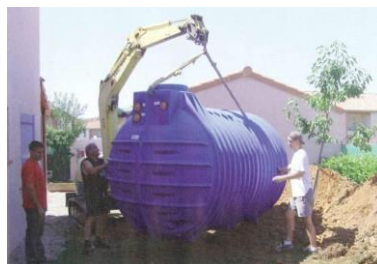
système de récupération individuel des eaux de toiture
