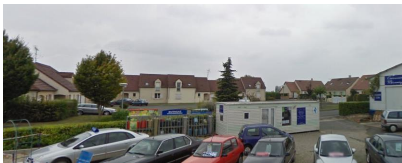
Opération des Charmilles vue depuis la RD2
