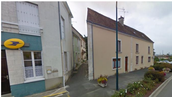
exemples de passage près de l'ancienne poste
