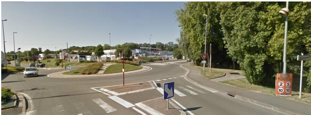
En sortie Sud de la ville de Mangers sur la RD2 : sortie de Mangers d'un côté du Rond-point
