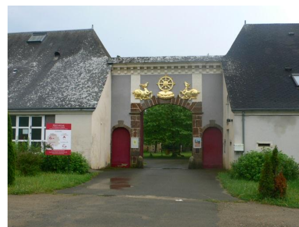
Entrée du Château de Segrais
