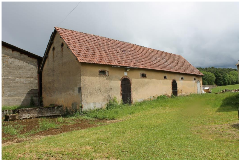
Photos du bâtiment identifié
