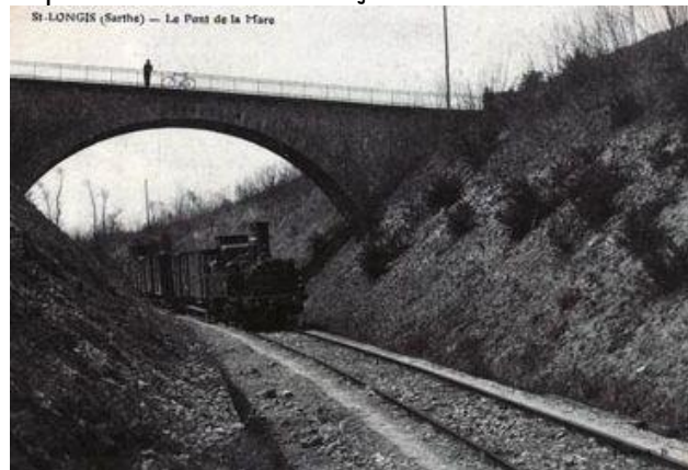
Ancienne voie ferrée
