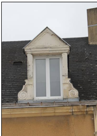
Exemple de lucarne d'une maison de bourg. Fronton et poteaux en pierre de tuffeau sculptés.
