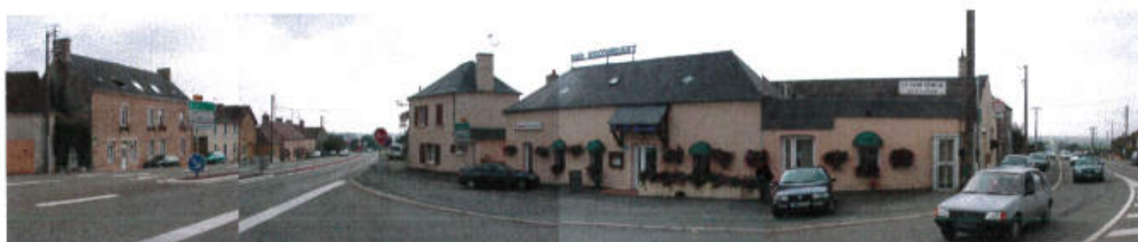
Carrefour entre les Rd 310 et 338 à la Hutte
