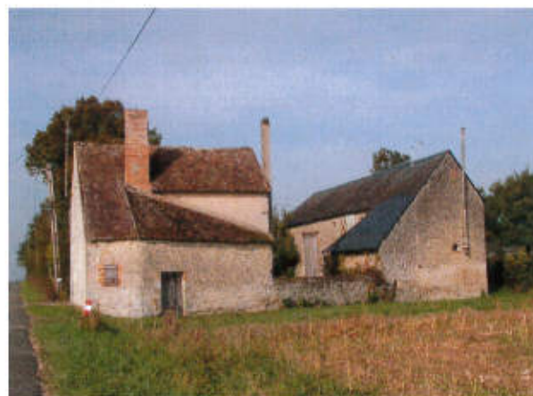
Bâti traditionnel au lieu-dit le Bourdin le long de la Rd 115
