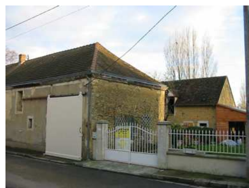
Rue des Croisettes n4 bis - 2
