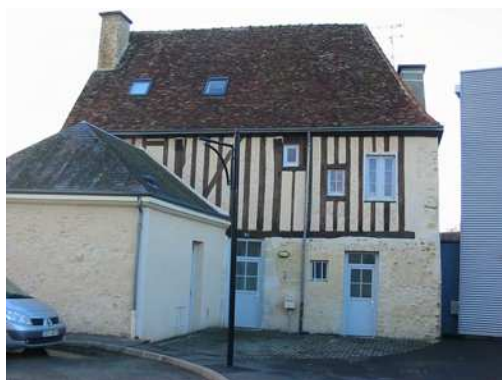
Rue nationale n°43 Façade Sud
