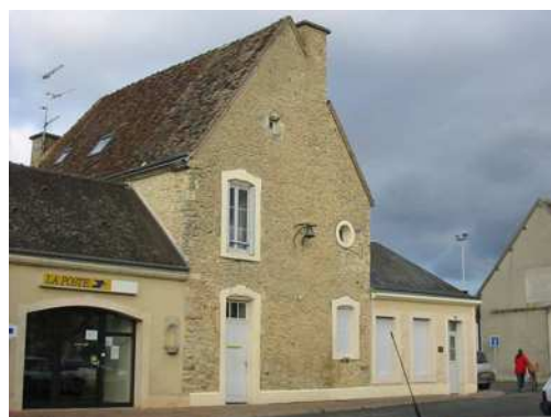
Rue nationale n°43 Façade Est
