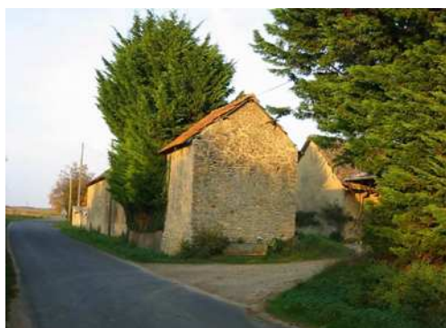
La croix de murs
