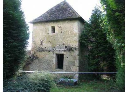
Four à pain Presbytère 32 rue nationale
