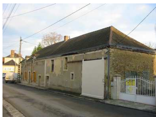
Rue des Croisettes n4 bis - 1
