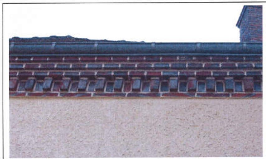
Exemple de corniche en briques
