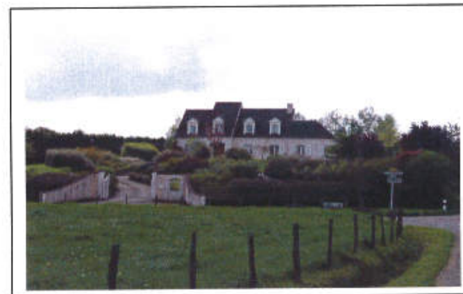
Pavillons situés au Nord de Contres
