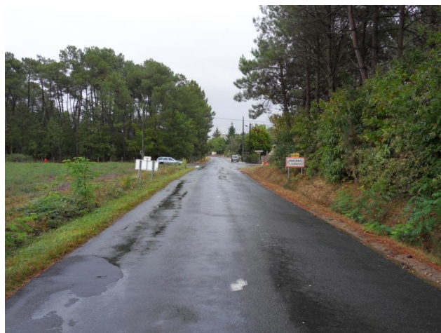
Entrée Nord-Ouest (D 250)
