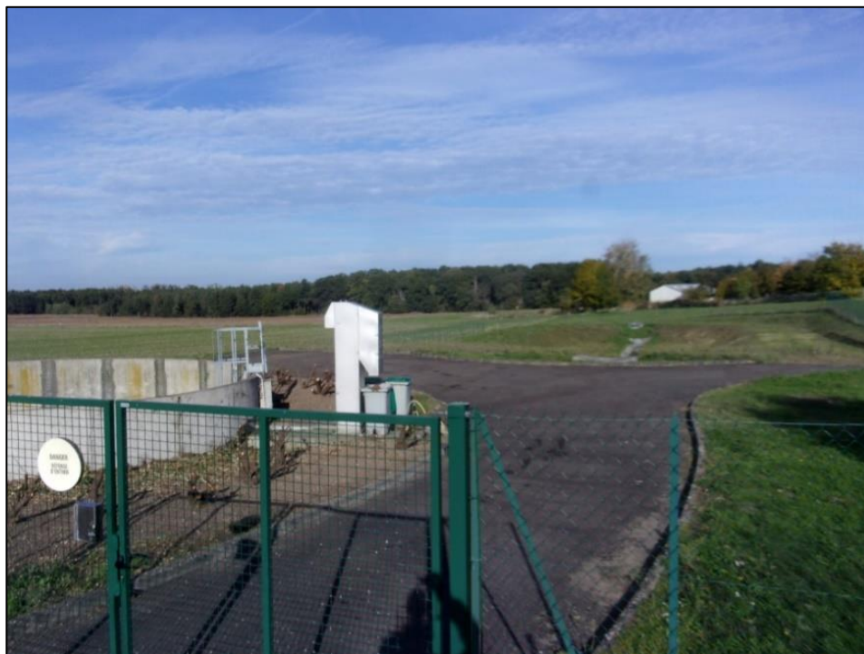
Vue du bassin tampon du réseau unitaire
