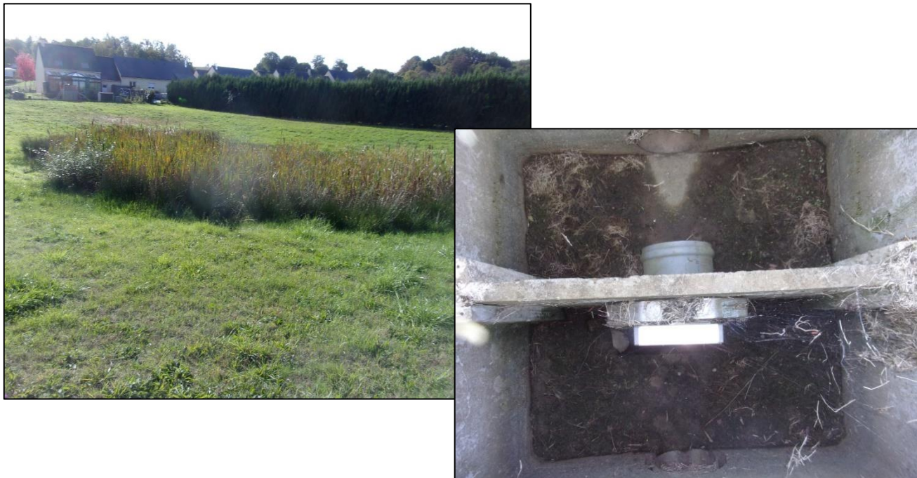
Vue du bassin d'orage Est du lotissement « La Plaine des Forges »
