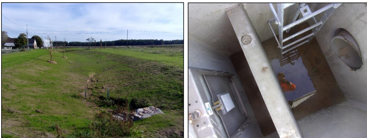
Vue du bassin d'orage du lotissement « Le Domaine des Lilas »
