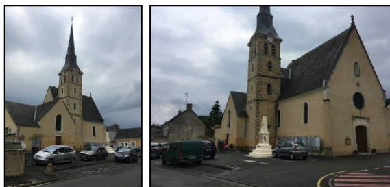
Aménagements de la place de l'Église
