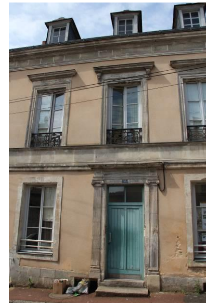
Immeuble du XIX ème siècle – rue Ledru Rollin
