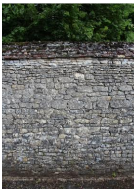
Mur en moellons, couronnement en petites tuiles plates
