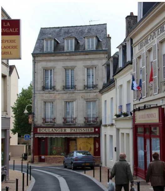
Immeuble du XIX ème siècle – rue du 115 ème Régiment
