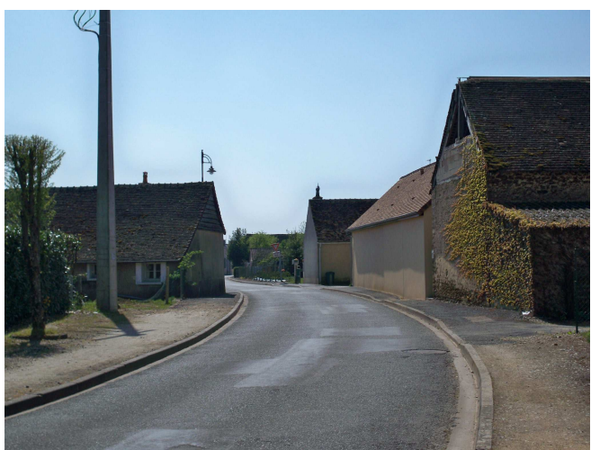
Route des Chapuisières, profil rural
