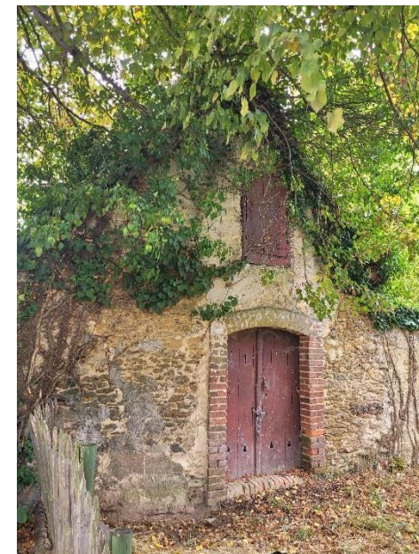
Annexe à restaurer
