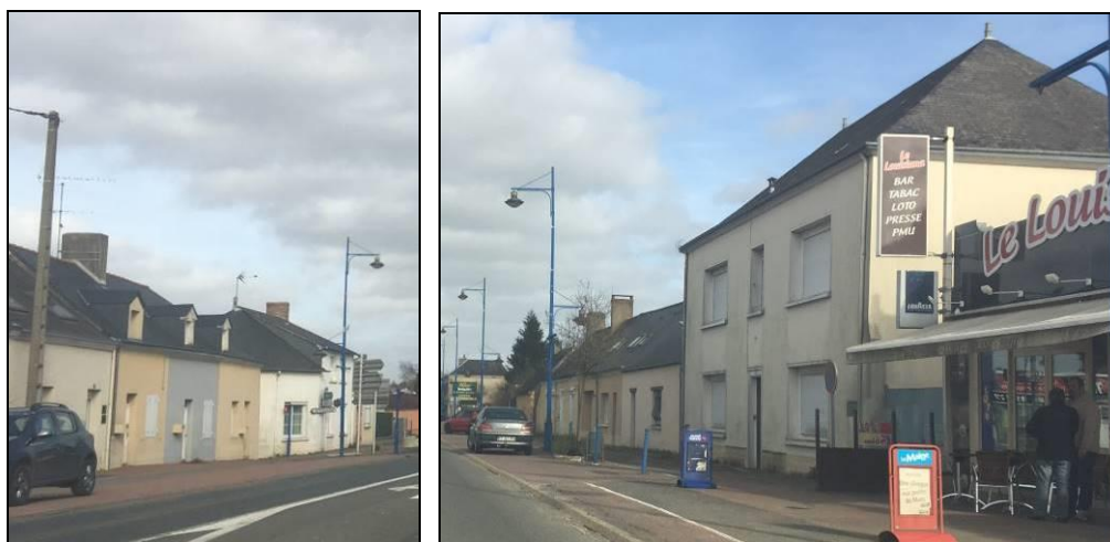
Photographies d'exemples de fronts bâtis dans le centre-bourg.
