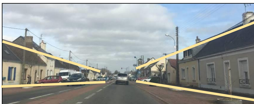
Représentation de la notion de perspective, générée par les fronts bâtis dans le centre-bourg.
