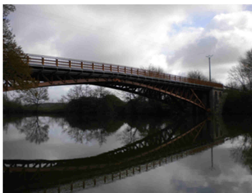
La structure du pont métallique depuis le bord de la Sarthe
