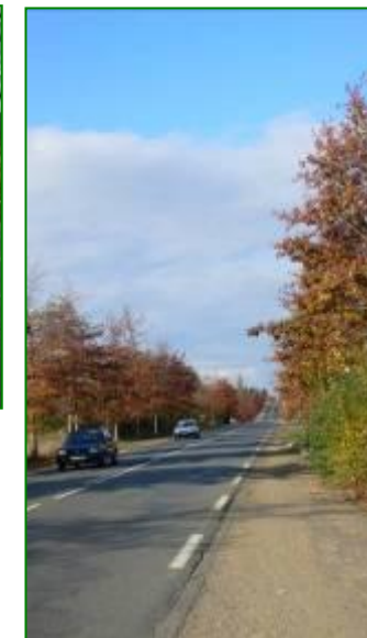
Chaussée non sécurisée pour les piétons en terre (avenue du Mans)
