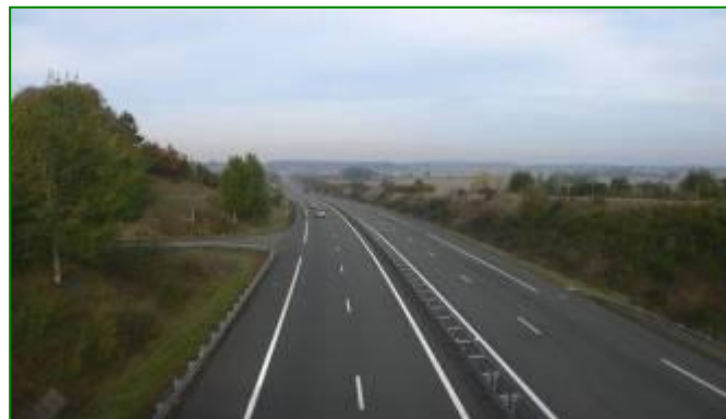
Tronçon de l'emprise autoroutière depuis le pont de la RD148
