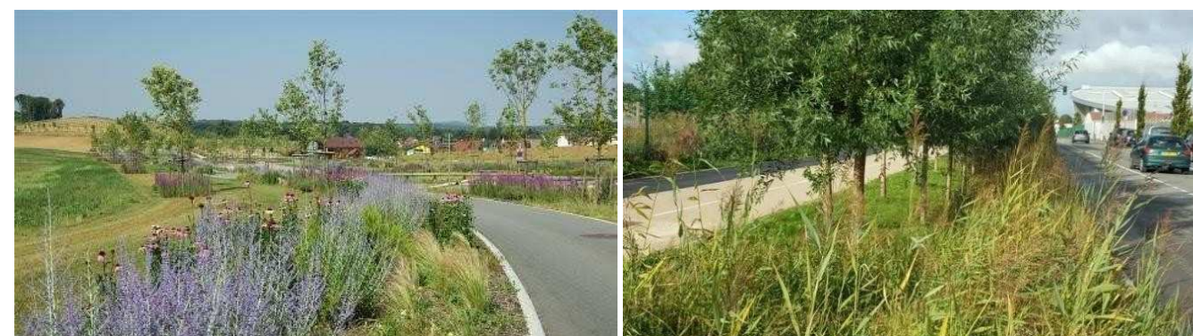
Photo 3 : Exemple de noues
