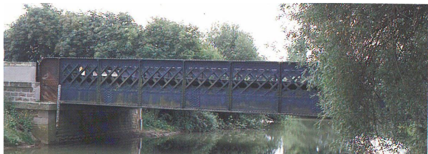
Le Pont de Couvarin
