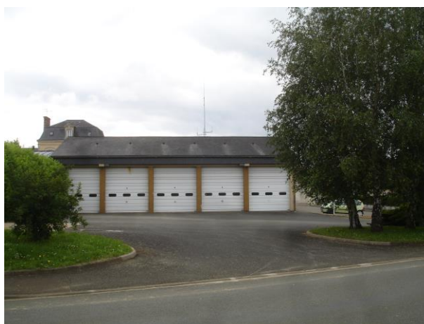
Centre de secours
