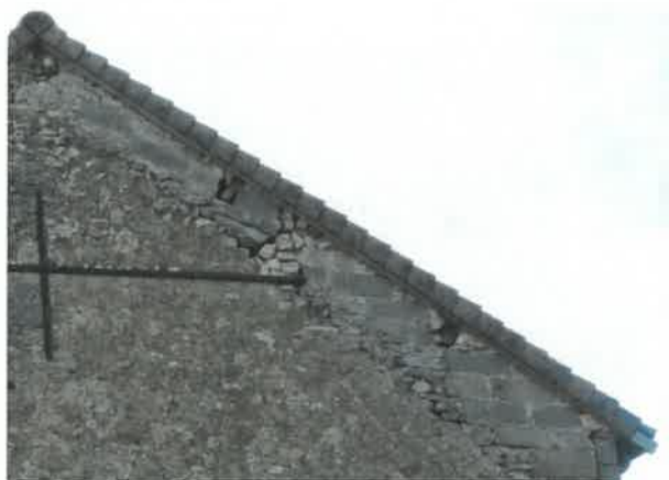
Toiture avec tuiles de rives à rabat
