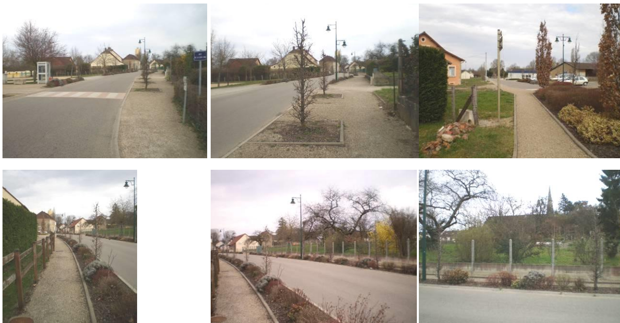
Aménagement rue du 16 juin 1944- photos 5 et 6, arrières de parcelles dont l'accès s'effectue par la rue du Bourg
