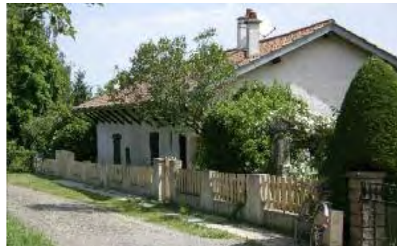
Clôture échalas en demi-rond en châtaignier écorcé ou à lames demi-rondes en pin massif.
