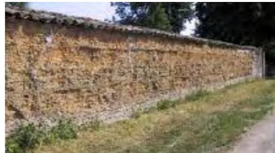
Mur en pisé avec soubassement en brique
