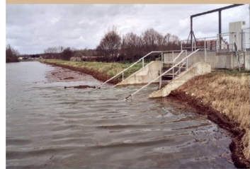
La digue d'Ouroux-sur-Saône (71)
