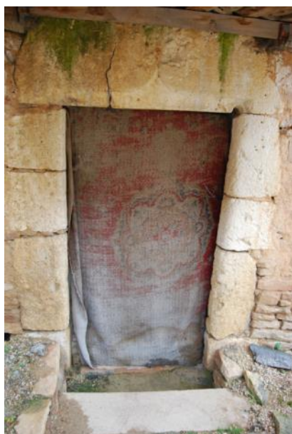
Figure 5 : porte basse, façade ouest. 2016.
