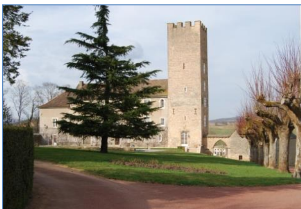
Figure 27 : vue d'ensemble de la façade sud en 2010.
