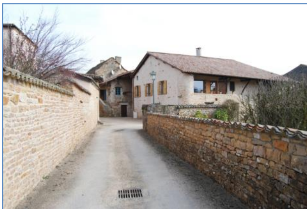
Figure 15 : au fond Impasse Saint-Laurent avec le toit de laves dépassant au-dessus des autres maisons. Depuis l'ouest (RD82). 2016.
