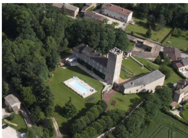
Figure 26 : vue aérienne. Cliché mairie de Laizé 2012.
