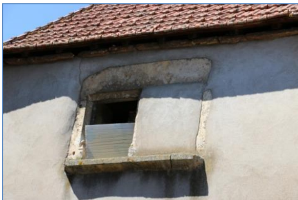
Figure 3 : fenêtre à meneau partiellement comblée, sur façade Est. 2016.
