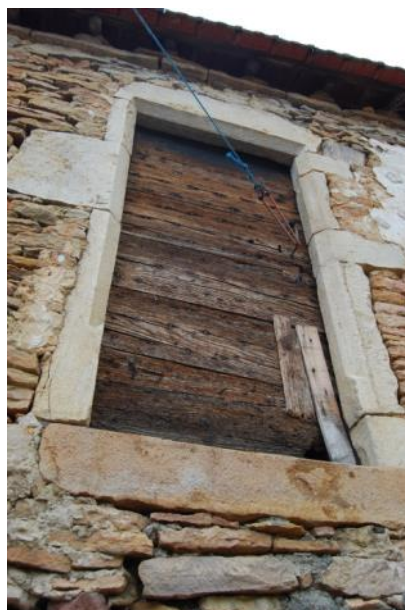
Figure 6 : porte niveau 1, donnant sur le vide, façade ouest. Chanfrein sur jambages et linteau. 2016.
