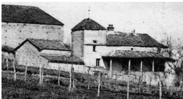
Figure 3 : agrandissement de la photo précédente permettant de remarquer les 4 piliers ronds en pierre de la galerie, les tuiles plates du toit, différentes au nord, partie agrandie en 1854. Remarquez le gros bandeau en pierre de la tour qui loge le pigeonnier, servant à empêcher les rongeurs d'atteindre le pigeonnier.
