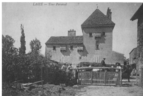
Figure 20 : « la tour Parseval » à Laizé vers 1900. Carte postale, collection de l'auteur.
