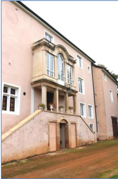
Figure 28 : vue de la façade nord du logis. 2016.
