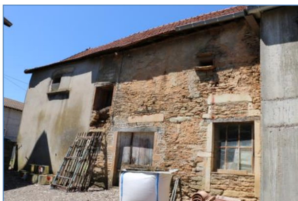
Figure 2 : la façade Est a été considérablement remaniée au cours des siècles. 2016.
