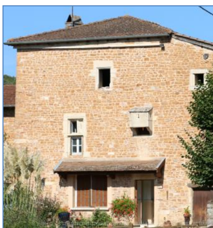
Figure 11 : façade sud. Aspect actuel.
