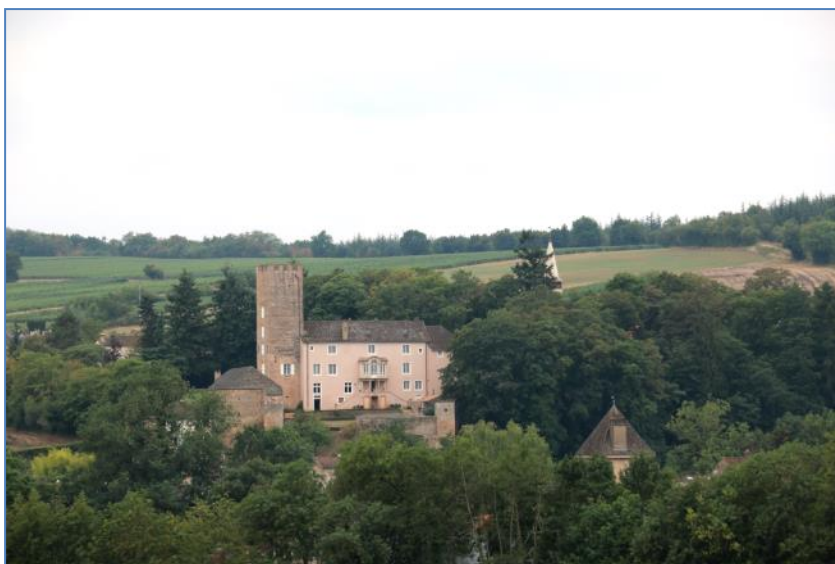
Figure 35 : vue d'ensemble, depuis la route de Clessé. Vue sur le toit de la tour Perceval, le doyenné et le clocher. 2016.
