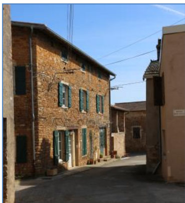
Figure 40 : ancien café « Maréchal », façade sud, donnant sur la rue Montlville. 2017.
