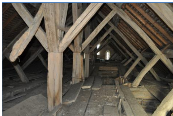
Figure 5 : charpente de la nef en 2012.
