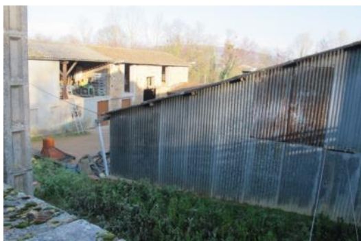
Bâtiment agricole en centre bourg
