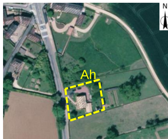
2- Un bâtiment d'habitation route de Mâcon
