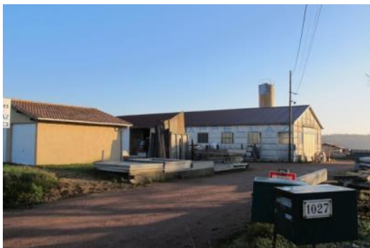
Atelier de préfabrication béton
