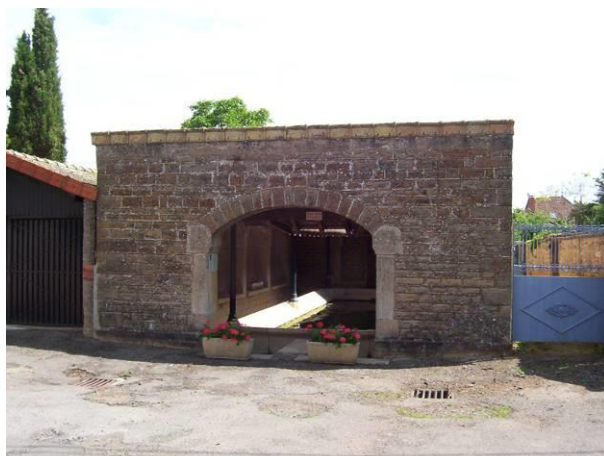
Le lavoir à impluvium
