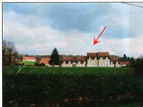
L'immeuble du Rompoix masque les vues sur le site depuis l'entrée ouest (RD200)
