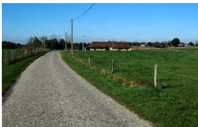
La voie communale n° 26 à la sortie de Marandin
