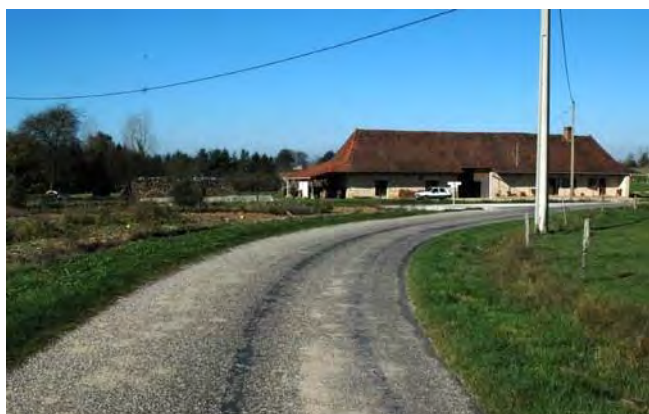
Habitation au carrefour des voies communales n° 26 et n° 11
