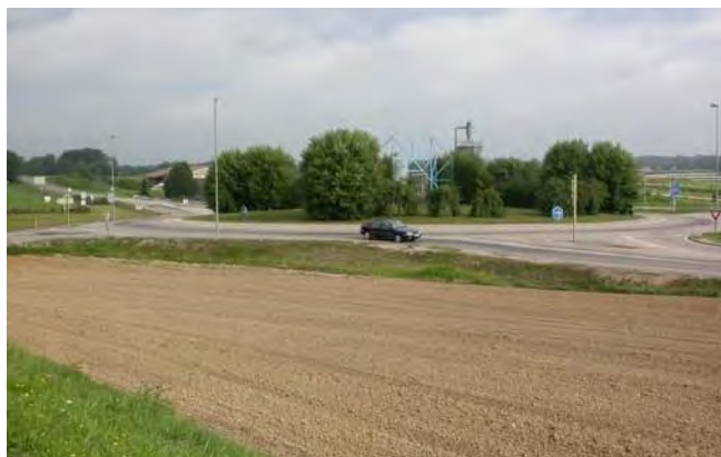
Le giratoire sur la RD972
