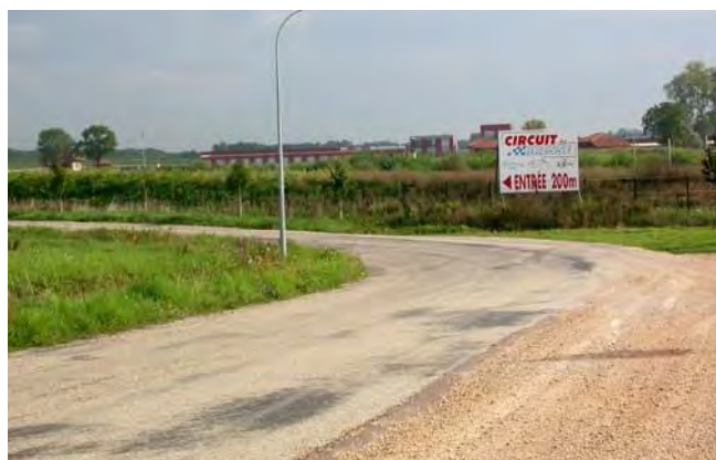
La voie communale n° 11 de la RD972 à Milleure
