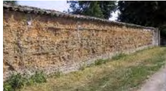
Mur en pisé avec soubassement en brique
