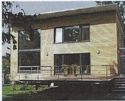
Maison passive ossature bois/remplissage bottes de paille (Autriche).
