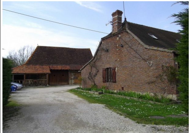
17. Préserver les pentes de toitures, aspect et matériaux de couverture, préserver les proportions des ouvertures, ordonnancement des façades, matériaux des façades (briques).
