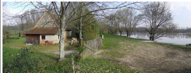
29. Ancien moulin des Claies
