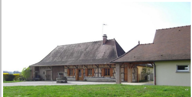
11 et 12. Rue du Bois Blanc Préserver les pentes de toitures, aspect et matériaux de couverture, préserver les proportion des ouvertures, ordonnancement des façades, matériaux et coloris des façades (colombages, briques).
