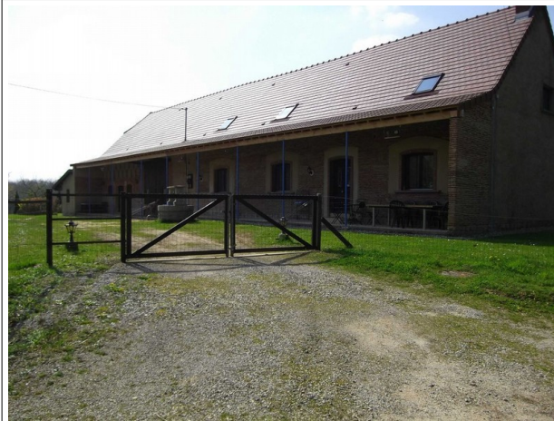
7. Hameau Les Folliets Préserver les pentes de toitures, préserver les proportion des ouvertures, ordonnancement des façades, matériaux et coloris des façades (briques), modénatures (linteaux...) – préserver le auvent.
