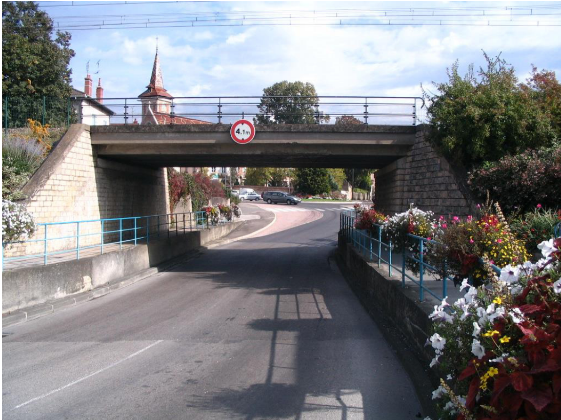
Selon la jurisprudence, un pont appartient au gestionnaire de la voie qu'il supporte. Ici, Réseau Ferré de France est propriétaire de l'ouvrage.
