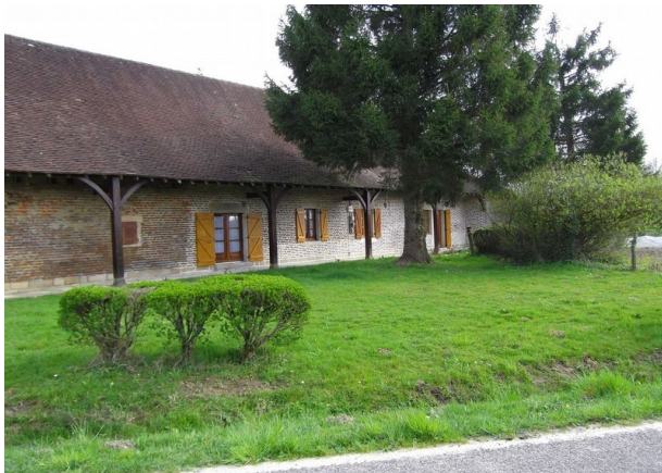
16. Préserver les pentes de toitures, aspect et matériaux de couverture, préserver les proportions des ouvertures, ordonnancement des façades, matériaux des façades (briques), – préserver le auvent.
