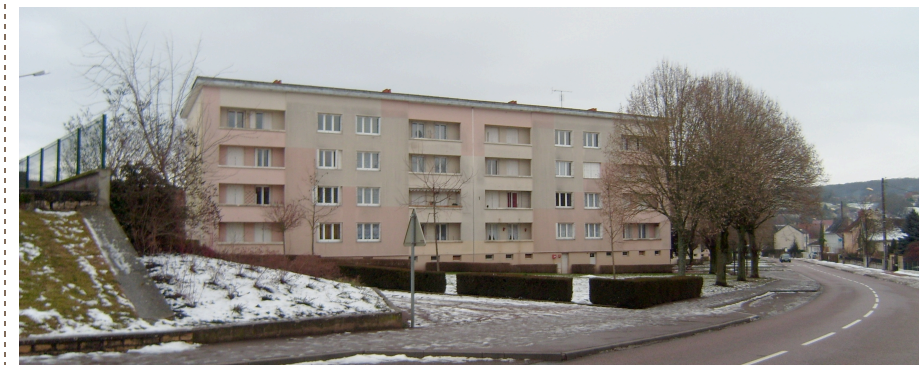
Immeuble collectif des années soixante
