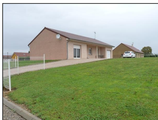
Constructions récentes dans le Lotissement des Ecoles
