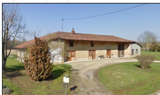
Habitation rénovée à CHEVALOT
