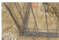
Noeud de chaînage - Continuité mécanique
