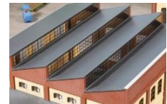
Toiture à redans partiels (shed)
