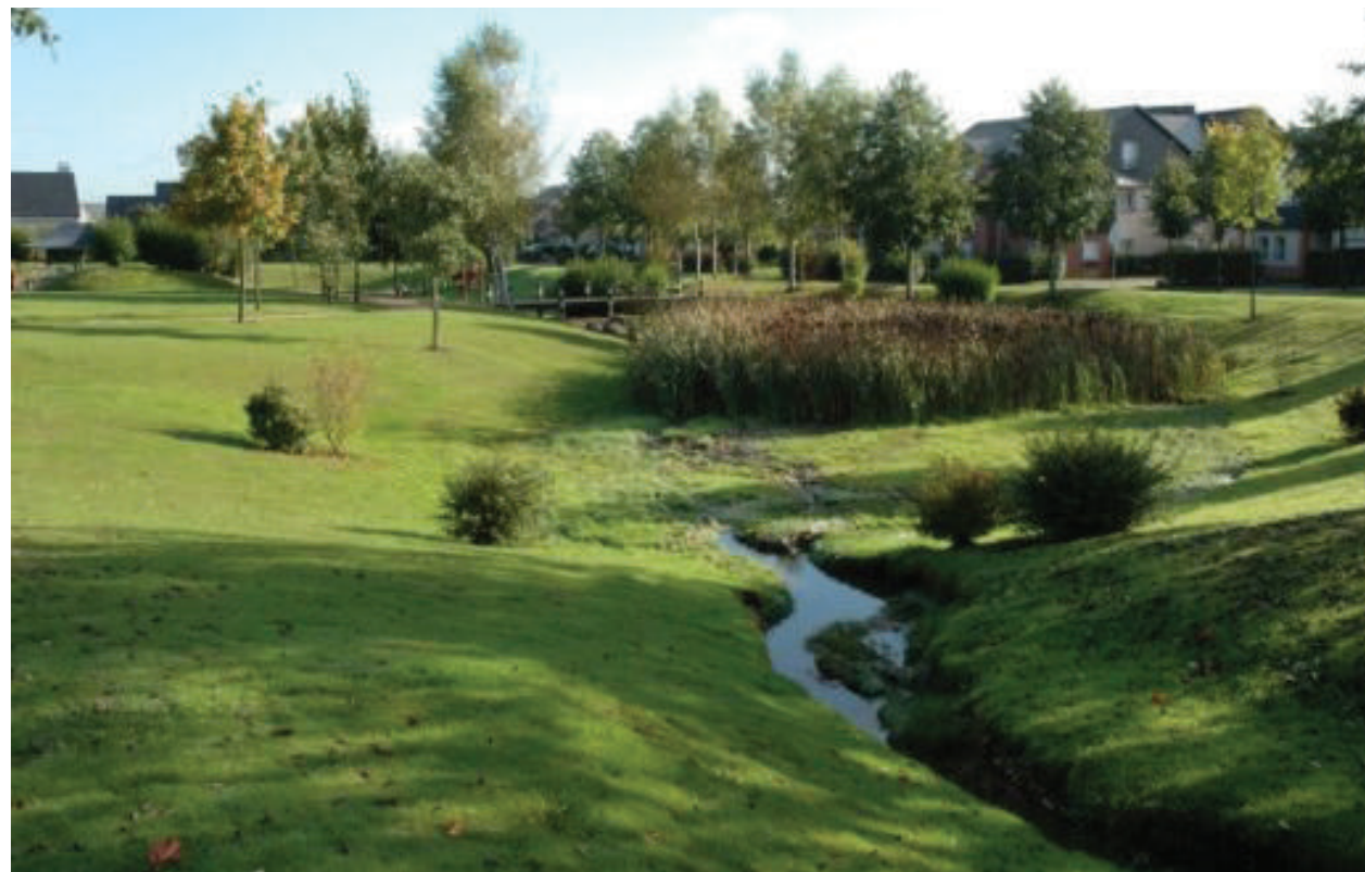
Bassin de rétention ZAC des Portes de la Foret
