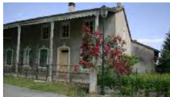
Clôture en métal et petit mur bahut surmonté d'un grillage
