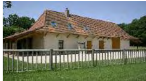
Clôture à piquets et traverses en pin
