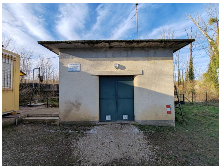
Le local technique du captage. Photographie prise le 23.01.2025.
