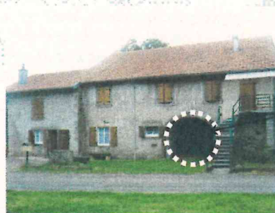
Construction ancienne à TERNUAY
