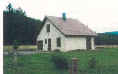
Construction récente à SAINT-HILAIRE : intégration architecturale de qualité
