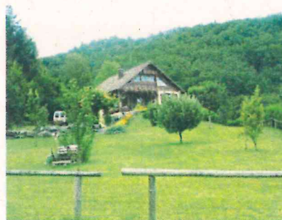
Construction sur remblais à TERNUAY
