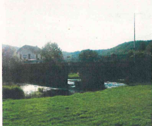
Le pont qui enjambe l'Ognon à TERNUAY
