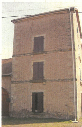
Ferme à la « tour carrée »
