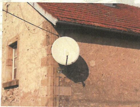
Parabole mal intégrée à la façade créant un impact visuel important
