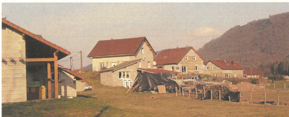
Extensions récentes remplaçant l'église au milieu du centre urbain
