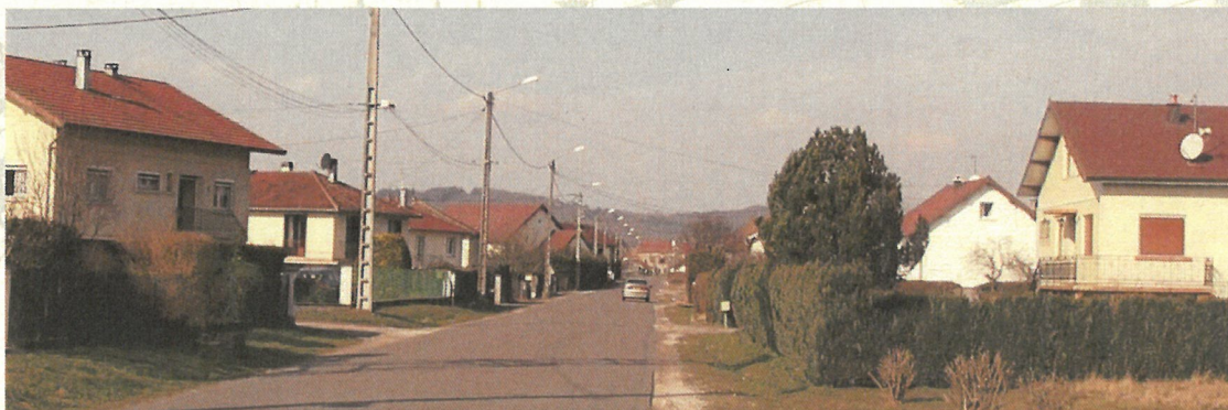
Sortie Sud de la commune vers Malbouhans par la RD 73
