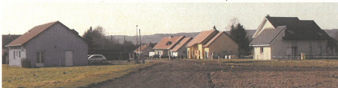
Lotissement (type 2), mal intégré dans le paysage communal sans cohérence architecturale
