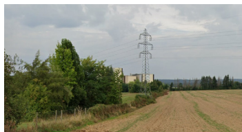
— Ligne HT 63 000 volts
