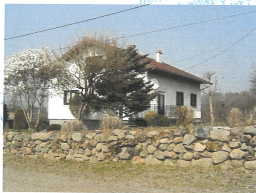
Construction des années 1970 à MONTESSAUX
