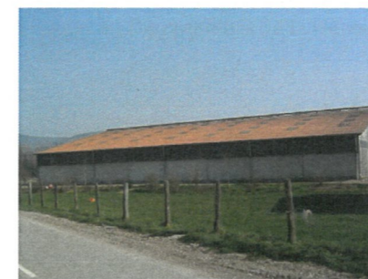
Bâtiment agricole générant un périmètre de réciprocité au lieu-dit Le Bas
