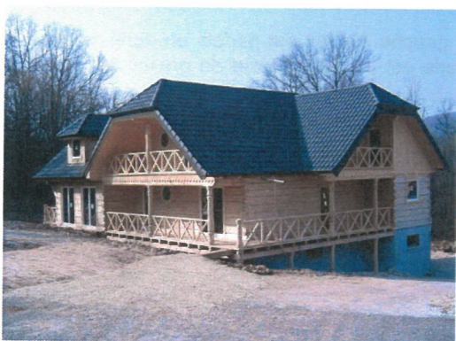
Bâtiment en cours de réalisation à proximité du lotissement
