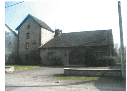
Réhabilitation d'une construction ancienne
