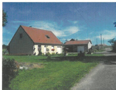
Extension récente au centre de La Lanterne
