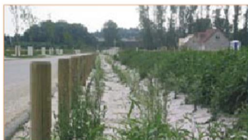
Une noue collectrice des eaux pluviales.
