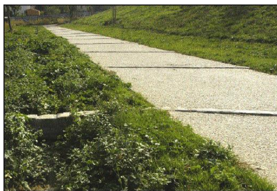
Allée piétonne et sa noue latérale
