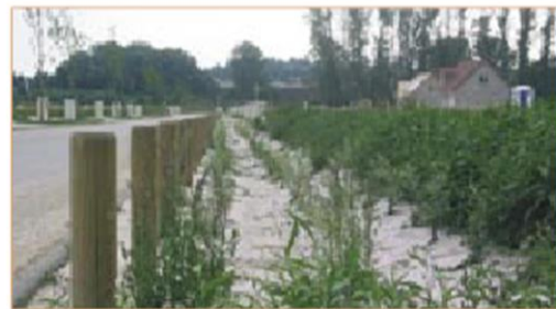
Une noue collectrice des eaux pluviales.
