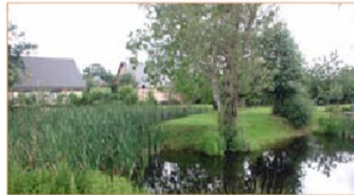
Un bassin filtrant collecte les eaux pluviales et participe à la qualité paysagère.
