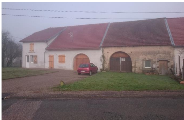
Photo : corps de ferme en bloc à Bougnon
