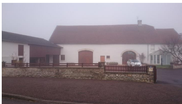
Photo : exemple de corps de ferme en équerre rénové à l'entrée Sud de Bougnon
