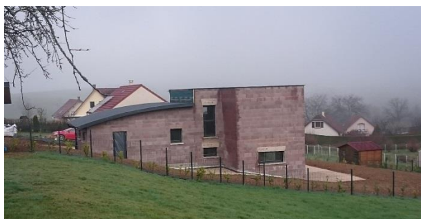
Photo : pavillon moderne en construction à Bougnon
