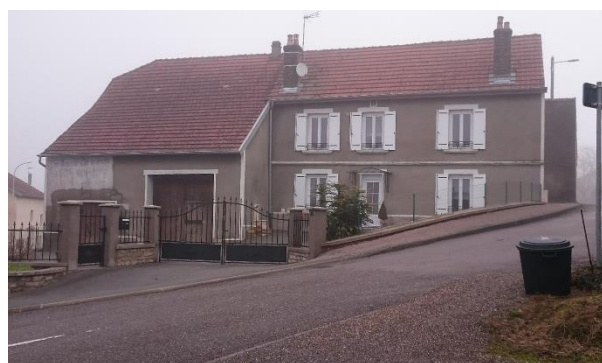
Photo : exemple de corps de ferme en équerre dans le centre-bourg de Bougnon
