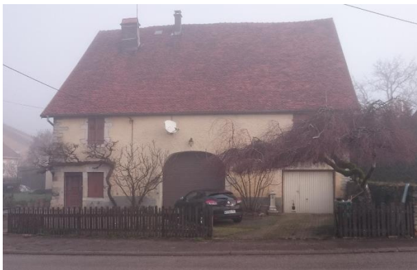
Photo : corps de ferme en bloc à Bougnon
